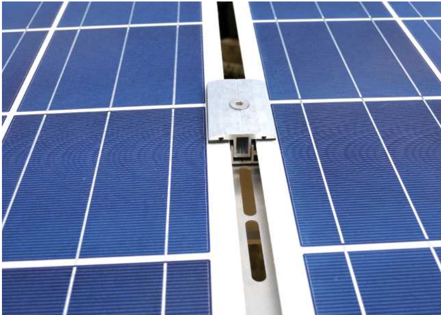
Die Modulhersteller schreiben unter anderem vor, wie lang die Laminatklemmen sein müssen, damit die Modulstabilität gewährleistet bleibt.
