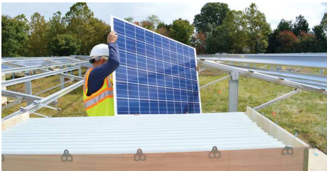
Ganz vorsichtig heben zwei Monteure die Module aus der Transportkiste.
