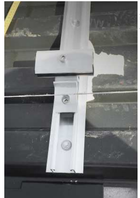
Die Handwerker müssen genau auf die richtige Positionierung der Klemmen achten.
