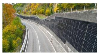
Die Verankerungstiefe von maximal 90 Millimetern durfte nicht überschritten werden, um die Statik der 75°-geneigten Stützmauer zu gewährleisten (Foto: Zenna AG)
