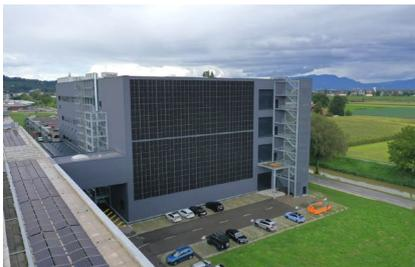
Les solutions de façade modulaires peuvent désormais être planifiées indépendamment par les planificateurs de K2 Base : K2 WallPV PerfoRail, MultiRail et FacadeRail.
