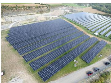
*Variabilité maximale : K2 N-Rack peut être monté sur des fondations pieux battus, comme ici dans un projet en plein air dans une zone de carrière, mais aussi sur des fondations en béton et vissées.*
