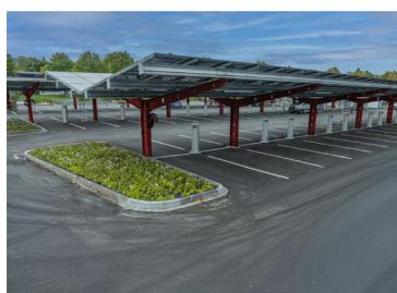
*Avec une hauteur minimale de 2 m et une hauteur maximale de 3,15 m, K2 Carport offre suffisamment d'espace et de protection pour les voitures compactes et les véhicules utilitaires plus hauts.*
