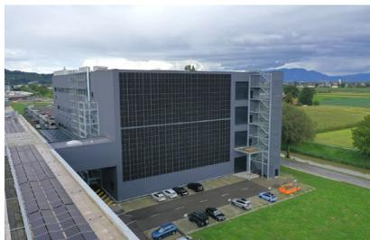
*As soluções de fachadas modulares podem agora ser planeadas de forma independente por planeadores em K2 Base: K2 WallPV PerfoRail, MultiRail e FacadeRail.*
