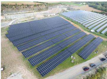
*Variabilidade máxima: K2 N-Rack pode ser montado em fundações de cravação de estacas, como aqui em um projeto ao ar livre em uma área de pedreira, mas também em fundações de concreto e parafuso.*
